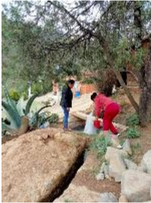
Encalamiento de Descargas
