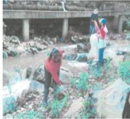
Chapeo, Limpieza y desazolve de barrancas
