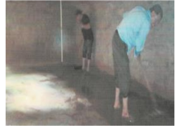
Limpieza y lavado de tanques de almacenamiento de agua potable
