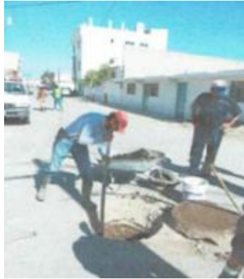
Limpieza y aplicación de cloro en redes de alcantarillado
